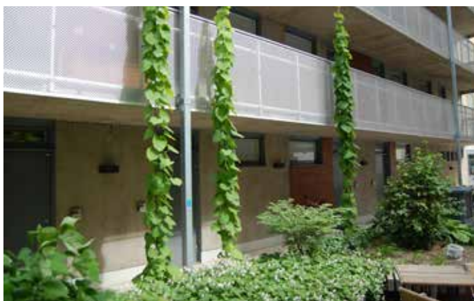
Klättrväxter på vajer på bostadsgård. Foto: Veg Tech AB.
